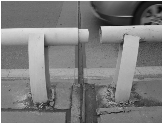
图 4 地裂缝引起的桥栏水平错动
