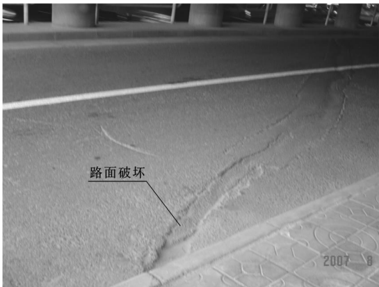
图 5 长安立交桥下路面破坏情况
