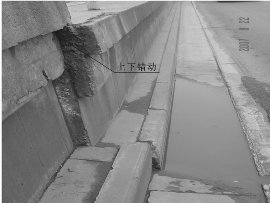
图 6 长安立交东北侧慢车道在地裂缝作用下的破坏
