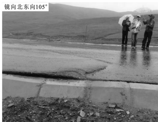
图 6 上盘公路路面压扭性破坏
