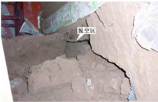
图 5 马蹄形隧道底部脱空现象
