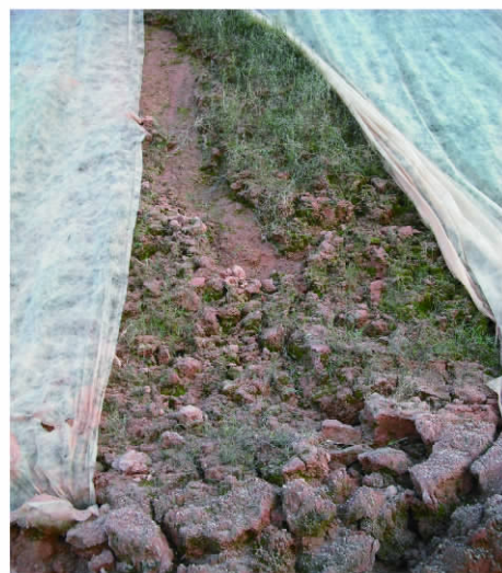
图 1 边坡浅层滑塌
