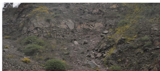
图4 滑坡体表面的裂隙
