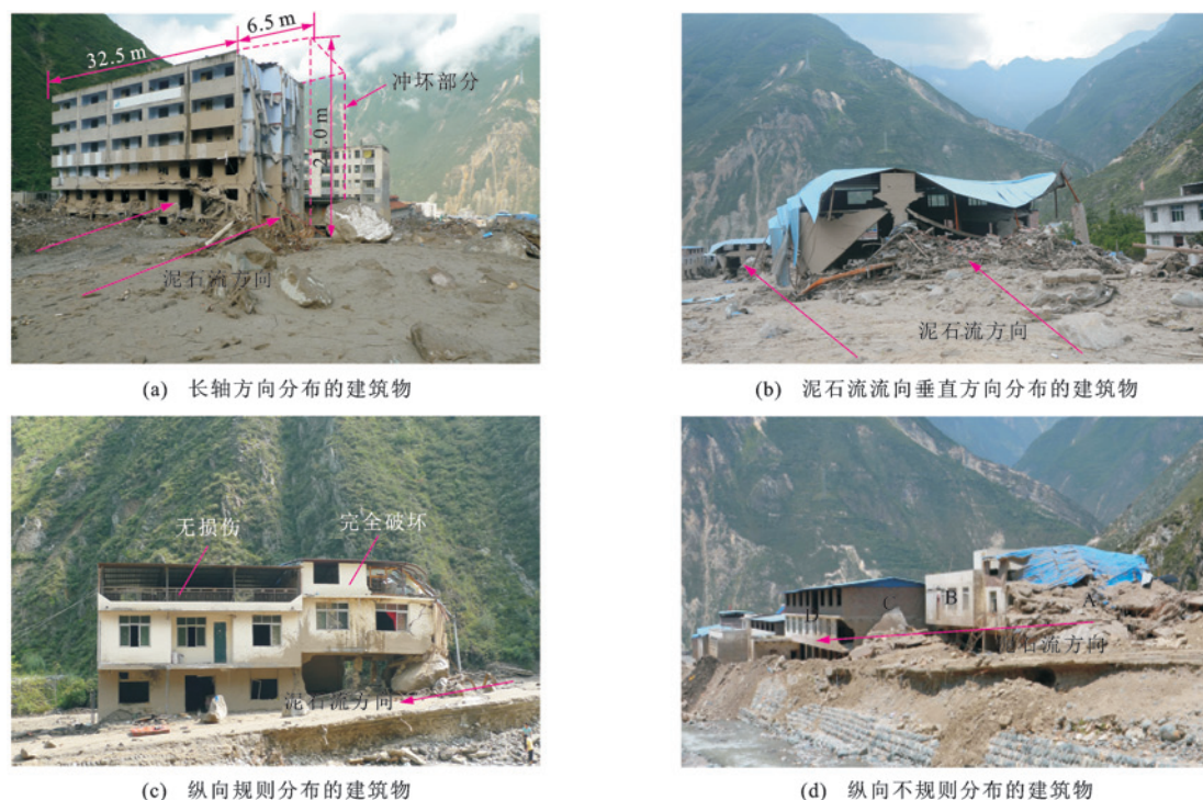
图5 七盘沟建筑物分布与泥石流破坏的关系
