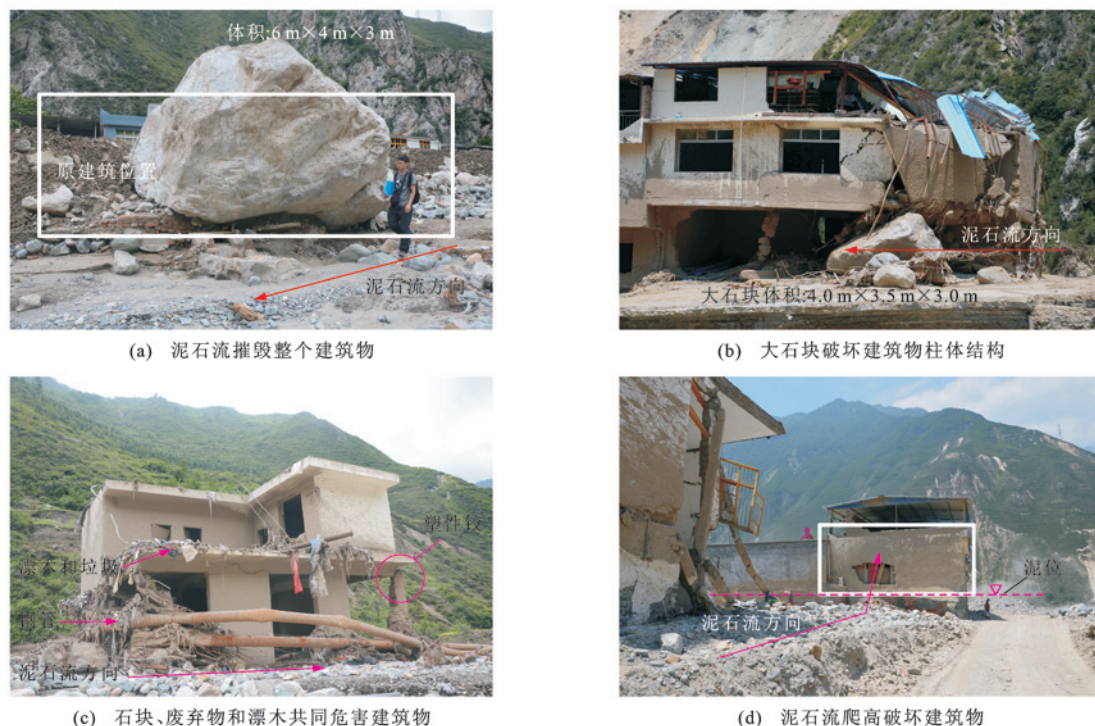
图4 七盘沟泥石流破坏建筑物的方式
