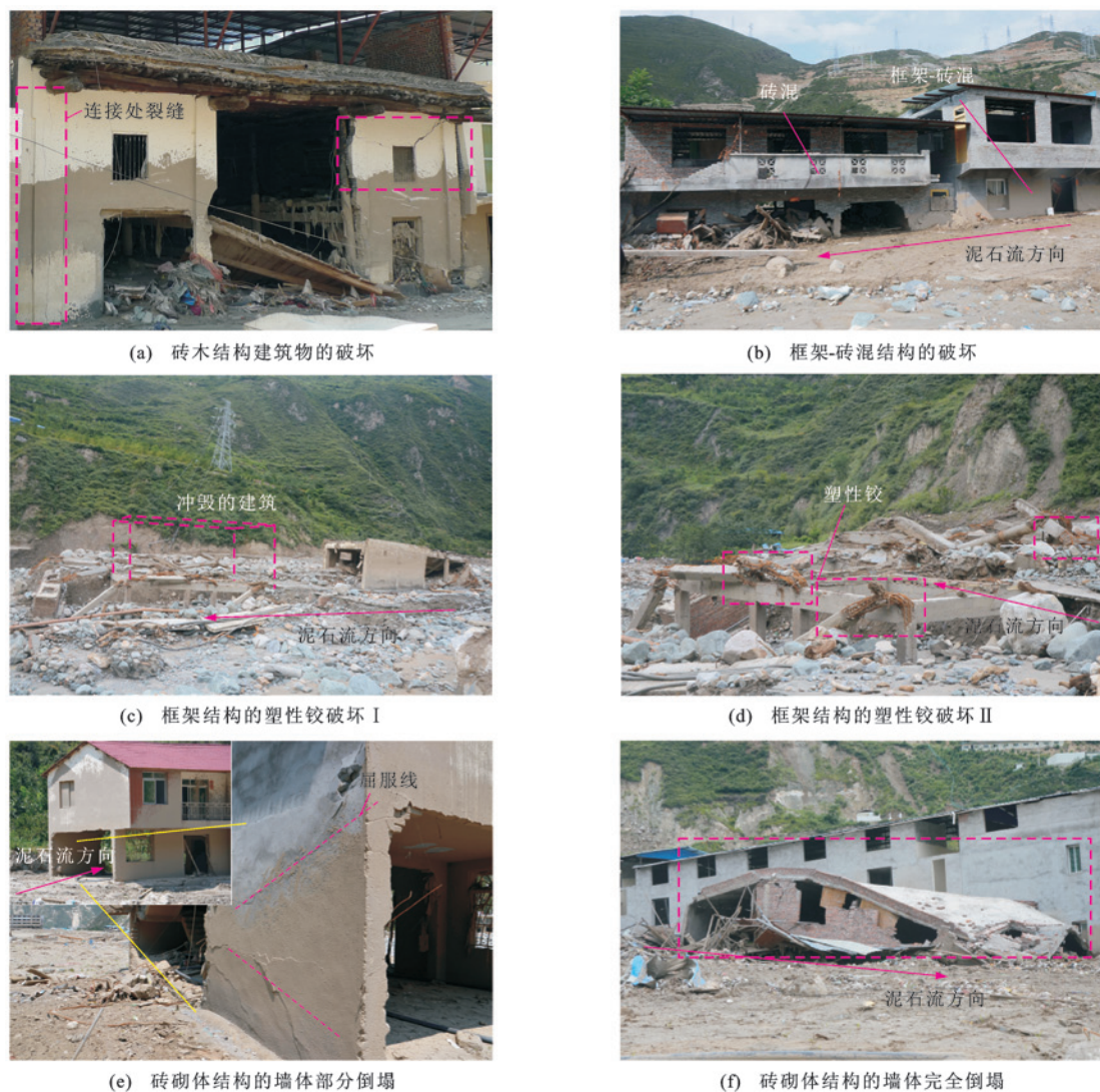
图6 七盘沟泥石流对不同结构建筑物的破坏模式
