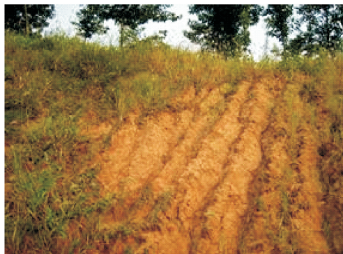
图7 未改良边坡的坡面
